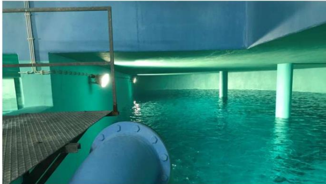
Eine der beiden Wasserklammern im Hochbehälter 1 an der Hohemark. Sie fassen zusammen 3000 Kubikmeter sauberes Trinkwasser. Dieses wird von hier auf die anderen Hochbehälter verteilt. cg © cg
