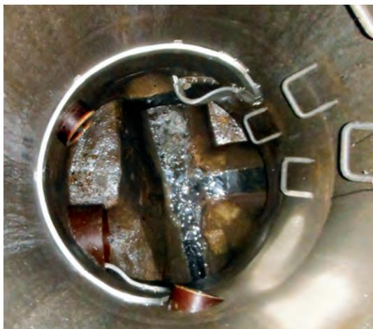
Zum Einsatz kommt das sogenannte „FAST“-Verlegesystem („Fibre Access by Sewer Tubes“) der Firma FastOpticom. Es ermöglicht die Verlegung von Kabeln in nicht begehbaren Kanälen. Dabei entsteht eine Leerrohranlage, so dass das Auswechseln der eingebauten Kabel nachträglich möglich ist. Verzweigungs- und Verbindungsstellen des Leerrohr-Netzes befinden sich in den Schächten der Kanalisation. Von dort wird auch die Verbindung zur „Außenwelt“, also zu den Sendeanlagen hergestellt.
