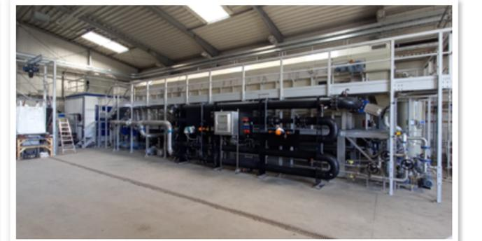
2021 neu auf der Kläranlage Grevesmühlen: Die Flotation für die Vorreinigung des Abwassers von Arla Foods.
